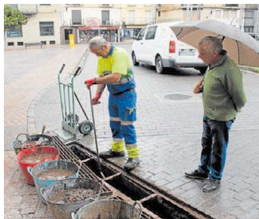
Un operario limpia las alcantarillas de la plaza de España. E. G. M.
