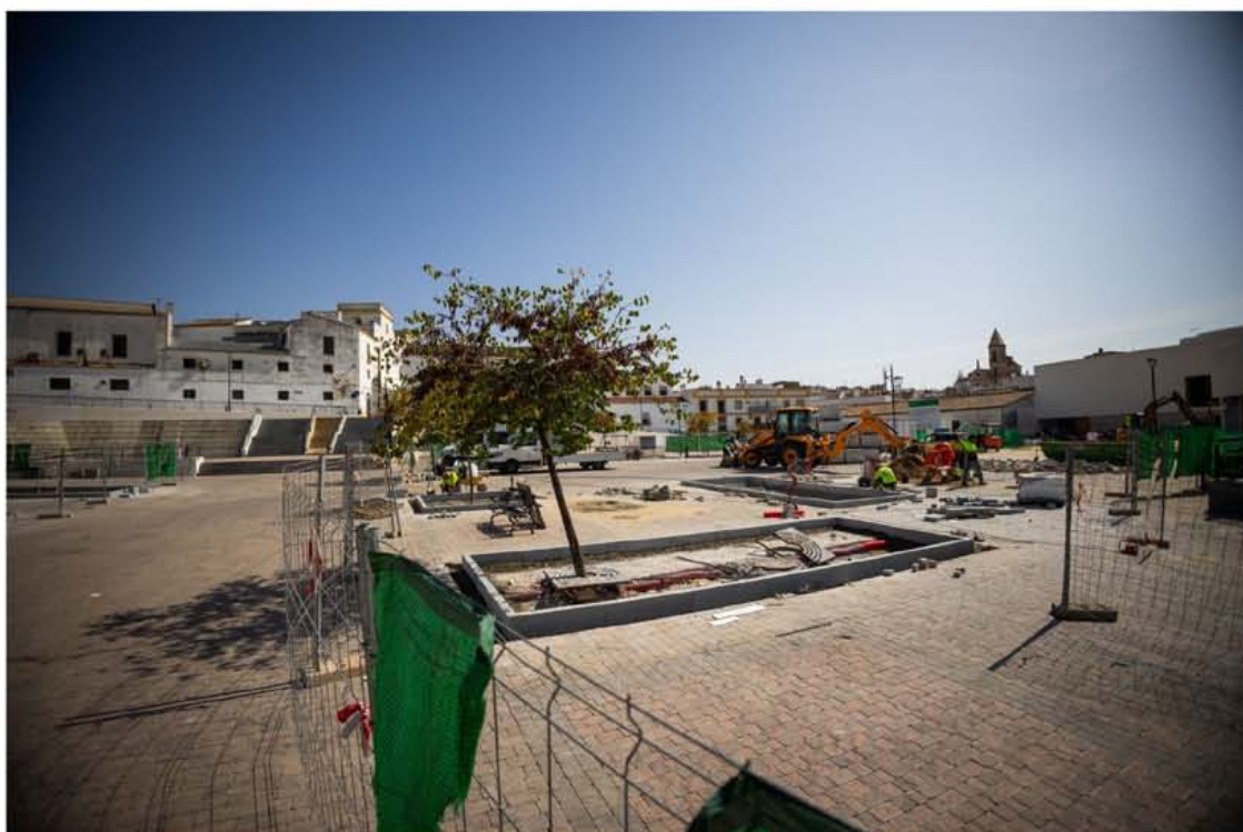
Vista general de la plaza Belén totalmente vallada
