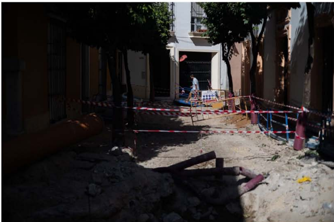
Un vecino de la plaza San Marcos entra en su casa con la calle totalmente levantadas por la obras
