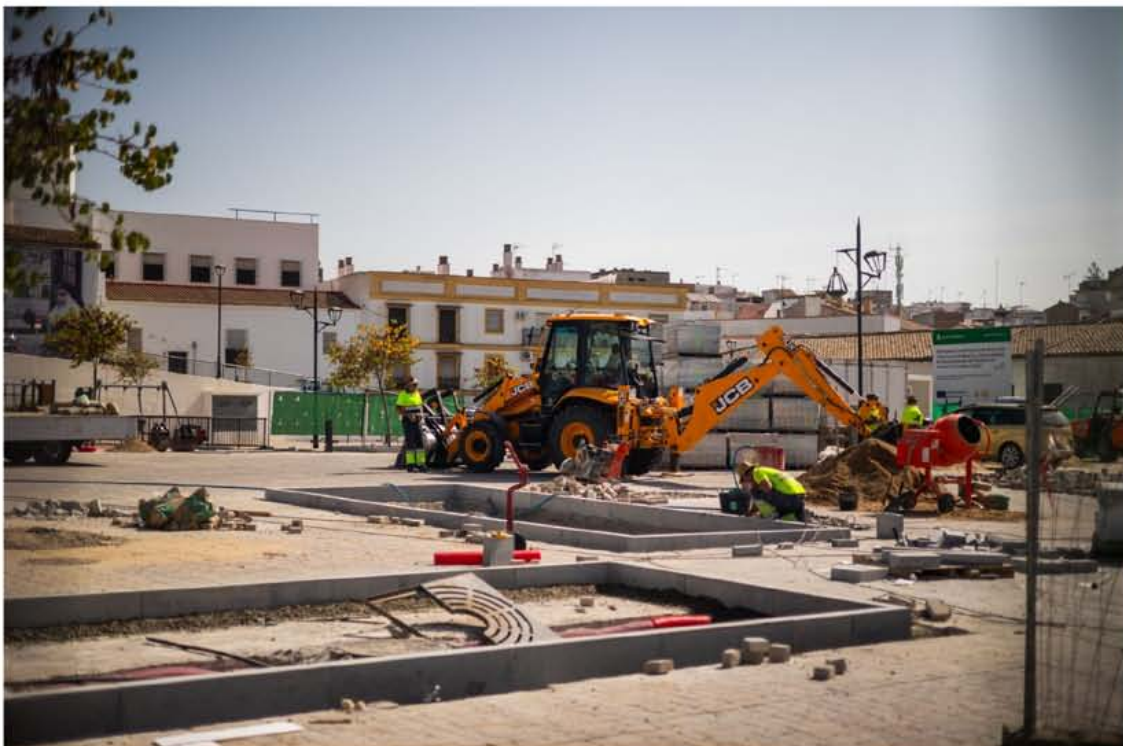
Trabajando en la mejora de la Plaza Belén
